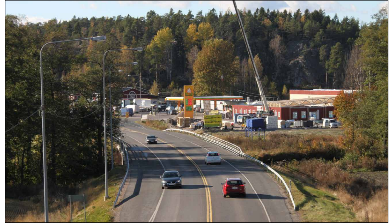
Kuva 39. Pikkalanjoen kohdalla nelikaistaistaminen edellyttää toisen sillan rakentamista nykyisen sillan etelä- tai pohjoispuolelle. Lokakuussa 2015 otetun kuvan taka-alalla on rakenteilla ABC-liikenneaseman uusi rakennus.
