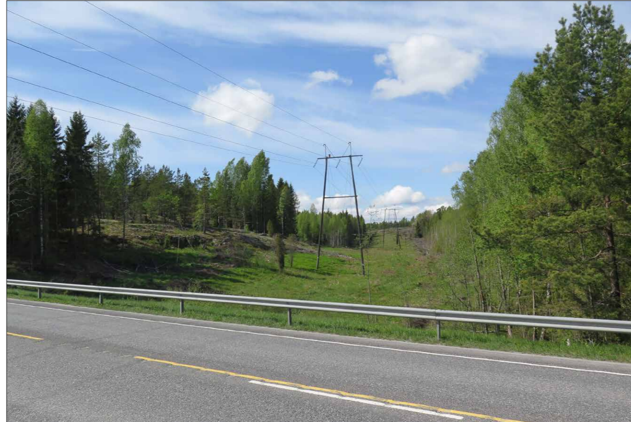
Kuva 38. Kuntarajan itäpuolella ekologisen yhteyden kohdalle esitetään rakennettavaksi eläinalikulku: kantatien tasaus nousisi 1,7 metriä, ja eläimille jäisi vähintään kuusi metriä korkea kulkutila ja yli 30 m leveä kulkutila.
