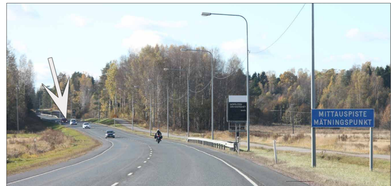
Kuva 23. Vuohimäen eritasoliittymän Karlbergintien vaihtoehdossa siltapaikka on tielinjalla olevan metsäisen kumppareen takana, mutta Karlbergintien ja ramppien penkereet suurelta osin oikealla näkyvälle Pedersin aukon länsipään pehmeikölle. Nuoli kuvassa osoittaa likimääräisen siltapaikan.
