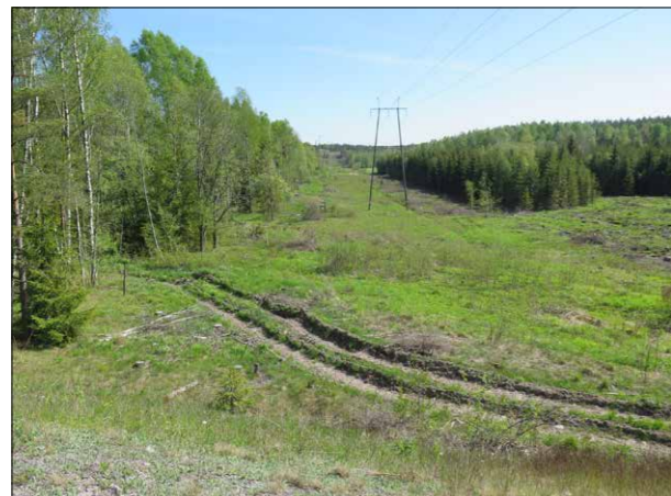
Kuva 27. Sähkölínjan vieressä kulkee tärkeä eläinten kulkureitti ja viheryhteys. Kuva kantatien penkereeltä etelään.
