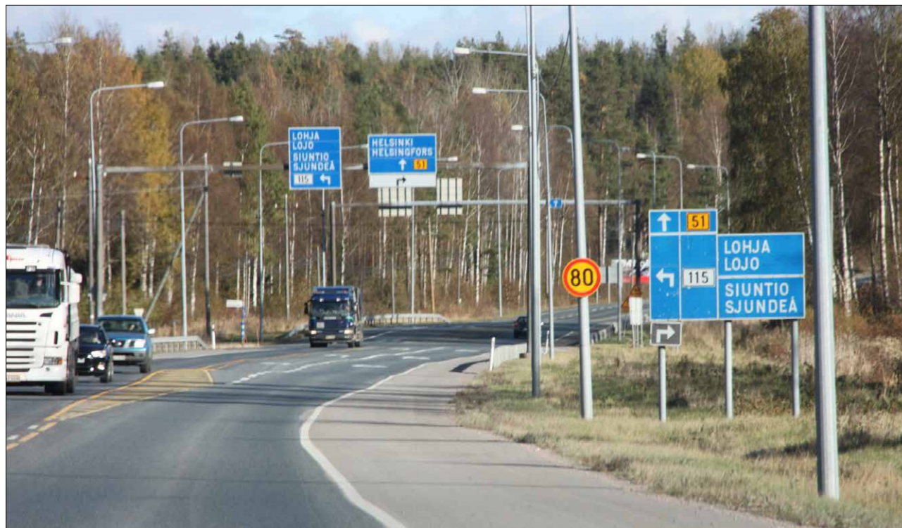
Kuva 41. Siuntiontien liittymä on suunnittelujakson liittymistä vilkkain, ja sen vuoksi myös kiireellisin sekä välityskyvyn että turvallisuuden parantamisen kannalta. Ensiaputoimenpiteenä suunnittelun aikana jo kuvan 80 km/h:n nopeusrajoitus (lokakuu 2015) kesällä 2016 liittymän kohdalla laskettiin 60 km/h:iin.
