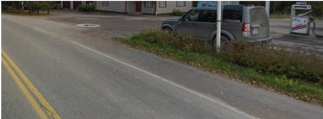
Kuva 4 Lappersintie tämänhetkinen levennetty piennar pyöräliikenteelle. Lähde: Google Street view 2019.
