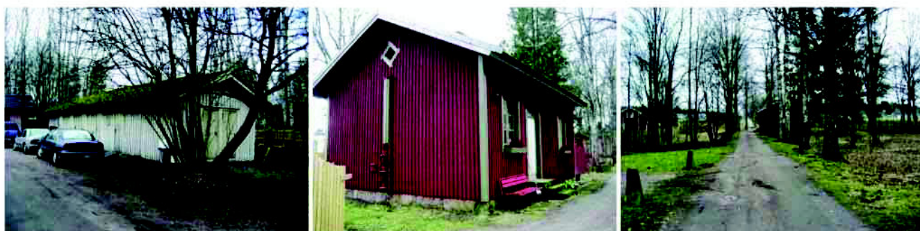
Pihan pohjoislaidalla on entinen ulkokäymälä (vasemmalla), entinen saunarakennus tulokujan varressa (kuvat keskellä ja oikealla).
