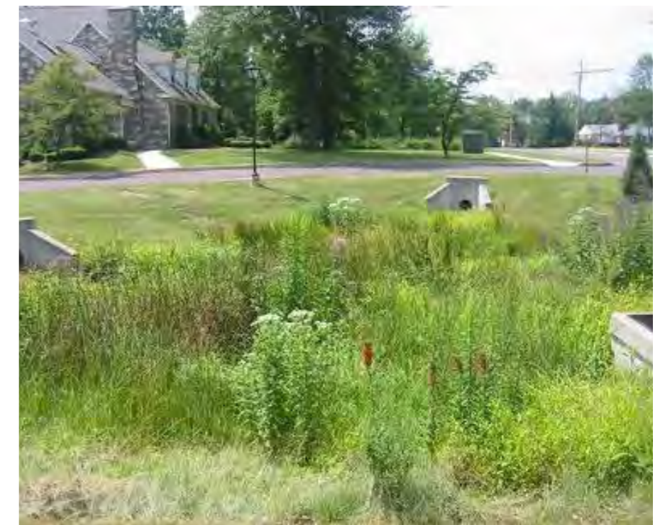
Kuva 20 Hulevesien imeytys- ja viivytyalueet voidaan suunnitella monipuolisiksi pihan viherelementeiksi. (kuvat: ylhäällä vasemmalla: Mayot & Toussaint (kuvaa muokattu), ylhäällä oikealla: GreenWorks, Russellville Commons, alhaalla: Low Impact Development, Opportunities for the PlanET region by University of Tennessee)
