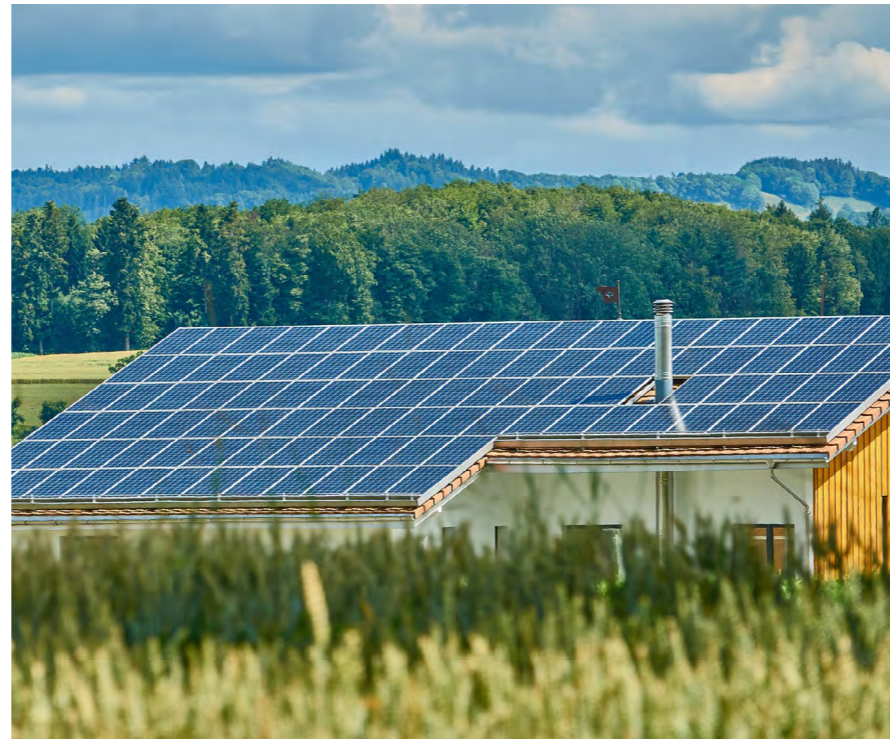
Kuva 23 Esimerkkikuva kattopinta-alan hyödyntämisestä aurinkopaneeleille. (kuva: kuvapankki)
