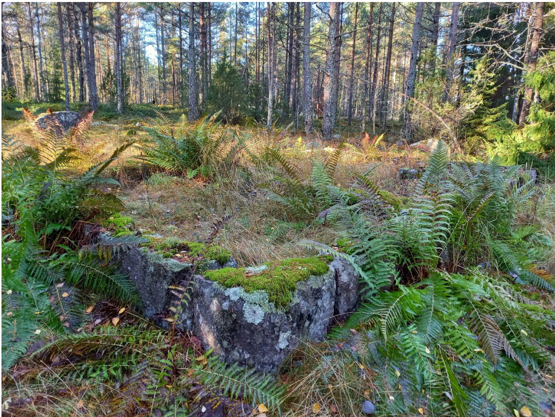
Kuva 2.3. Torpan kivijalka. Kuva: Maisema-arkkitehtitoimisto Maanlumo Oy, 2023
